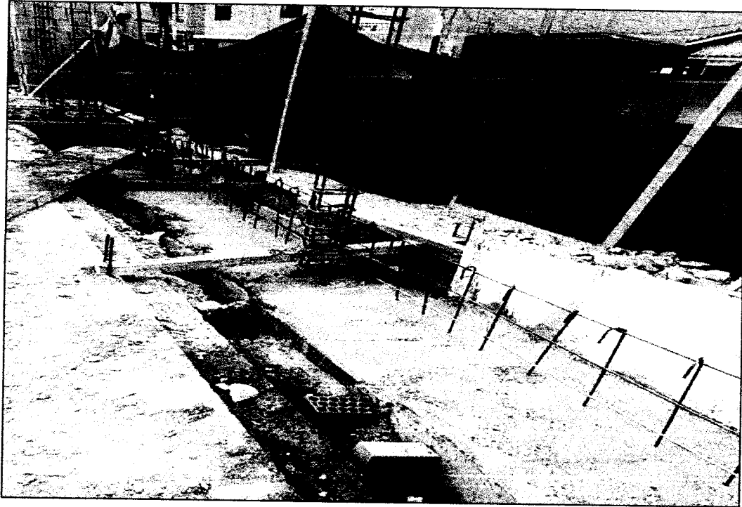
Foto N°05: Concreto en los cimientos del cerco perimétrico
